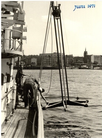
Erprobung des Vibrationsstechrohrs im Rostocker Stadthafen (Foto: K. SCHMEDEMANN).
