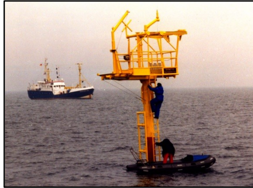
Arbeiten mit FS „Professor Albrecht Penck“ am MARNET-Messmast „Darßer Schwelle“ im September 2000 (Foto: H. SEEHASE).
