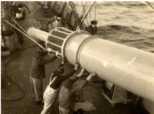
Teilansicht vom Unterwasserteil der hydro-meteorologischen Boje mit Käfig, in dem die Messfühler untergebracht werden sollten, beim Auslegen vom VS „Joh. L. Krüger“ im Juli 1957.
