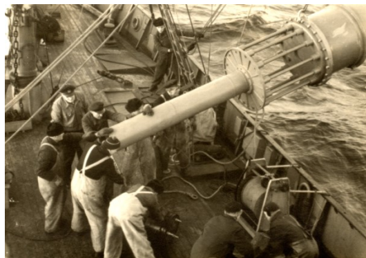
Teilansicht vom Unterwasserteil der hydro-meteorologischen Boje mit Käfig, in dem die Messfühler untergebracht werden sollten, beim Auslegen vom VS „Joh. L. Krüger“ im Juli 1957.
