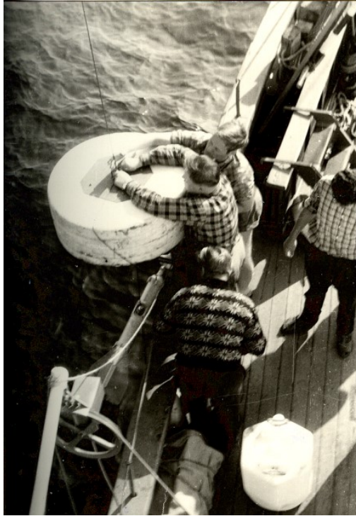
Abb. 34: Erstes Entwicklungsmuster einer Stömungsmesserboje (Foto: IOW-Bildarchiv).
