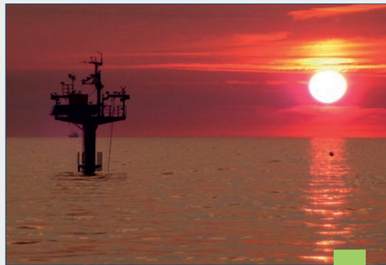
Abb. 3: Die IOW MARNET-Station Arkona See nach der Generalüberholung im Juni 2012. / Fig. 3: IOW MARNET station Arkona Sea after general overhaul in June 2012. (Foto / Source: IOW)
