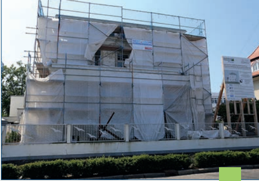
Sanierungsarbeiten an der zum IOW gehörenden Villa in der Seestraße 15. / Refurbishment at our building 'Villa' in the Seestraße 15. (Foto / Source: IOW)
