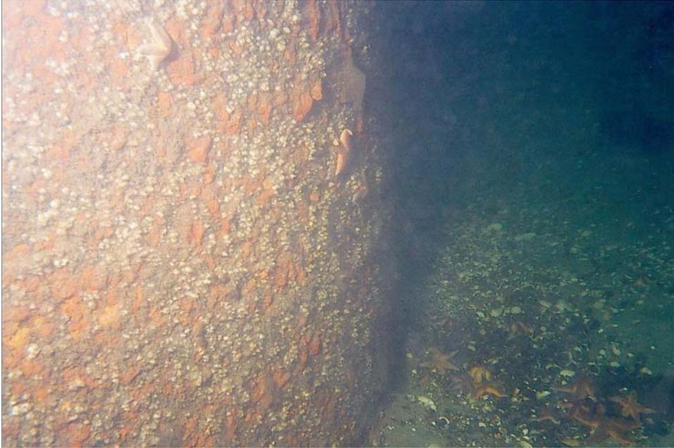
**Abb. 26:** Mai 2004 (nach 417 Tagen): Die Auskolkung hatte sich stabilisiert. Die Tiefe betrug wie im Dez 2003 30 bis 40 cm. Schill verfestigte das Sediment. Vom Stahlrohrsegment abgefallene Biomasse diente v.a. Seesternen und Strandkrabben als Nahrung.
