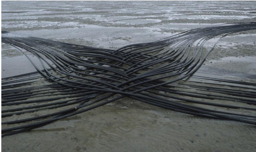
**Links: Hochspannungs-Gleichstrom-Übertragungskabel für die Netz-anbindung der Offshore Windcluster „HelWin“ (nordwestlich von Helgoland) und „SylWin“ (westlich von Sylt). Sie liegen mindestens 1,5 Meter, bzw. in Schiffsverkehrsgebieten 3 Meter unter der Meeresbodenoberfläche.**
