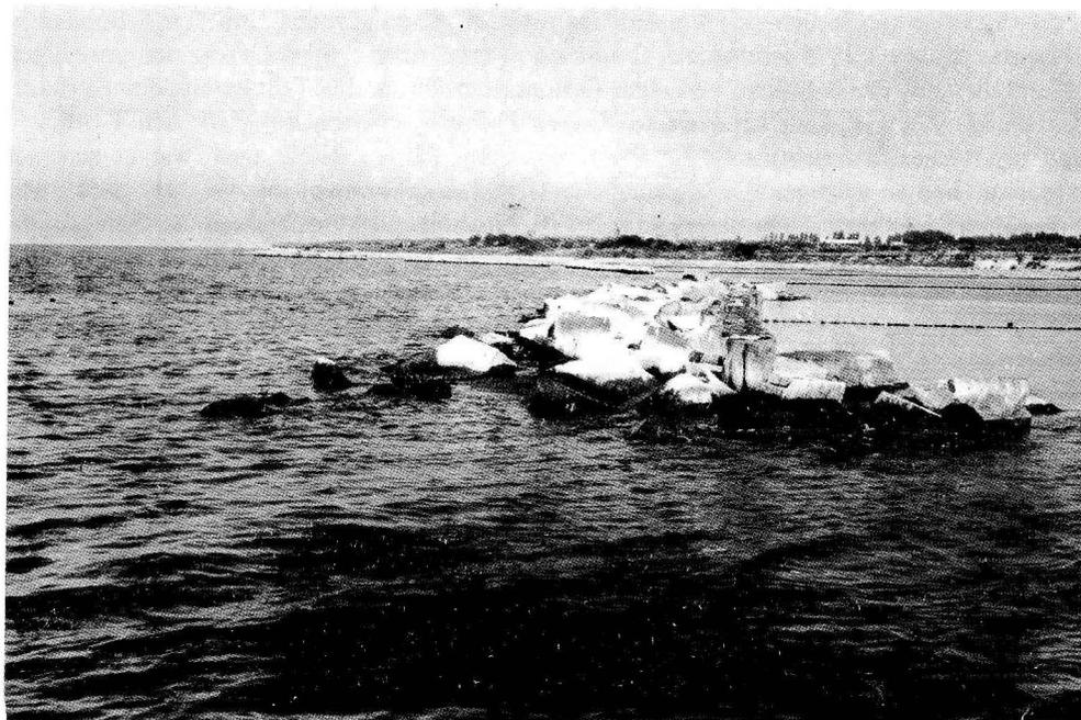
Abb. 27. Südlicher Abschluß des Natursteinwellenbrechers (Seegangssonden abgebaut) 1981. — Blick in Richtung Rehbergort
