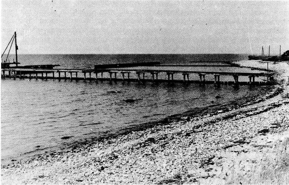
Abb. 18. Rammung der küstenparallelen, doppelreihigen Holzpfahlwand vor Buhne Nr. 5, 1973. — Blick wie Abb. 17
