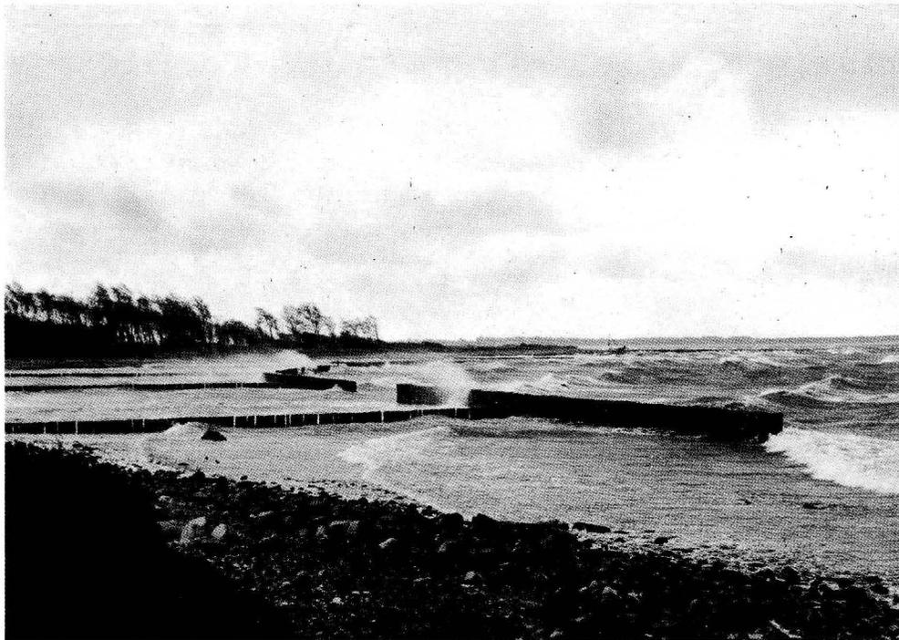
Abb. 19. T-Buhnensystem im Wellenangriff. — Blick von Rehbergort in den Grünen Grund
