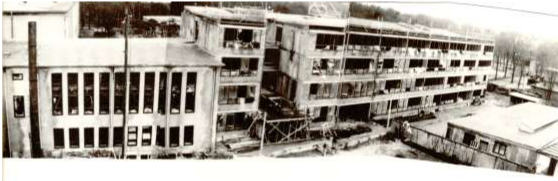
Abb. 35: Saal- (links) und Laborgebäude (rechts) sowie Hofgebäude (rechts unten) im Bau (Hofseite; Stand: Januar/Februar 1965) (aus TIMM, 1977, Bd. 4).
