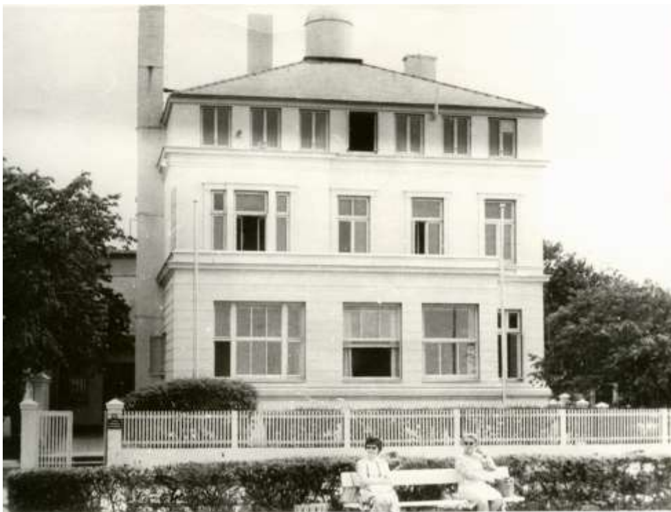
Abb. 34: Das Dienstgebäude des Ostsee-Observatoriums Warnemünde des SHD in der Seestraße Nr. 15 im Jahre 1957 (oben; Foto: W. MATTHÄUS) bzw. des Instituts für Meereskunde der DAW im Jahre 1960 (Foto: IOW-Bildarchiv).
