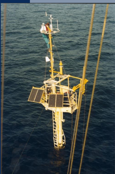
Messmast Darßer Schwelle
